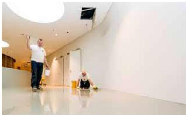
**STEP 4.** Una vasta gamma di prodotti in resina è disponibile per affrontare qualsiasi tipo di esigenza. Ad esempio, le chips decorative o gli inerti possono essere applicati sulla resina ancora fresca per ottenere un effetto antiscivolo.
