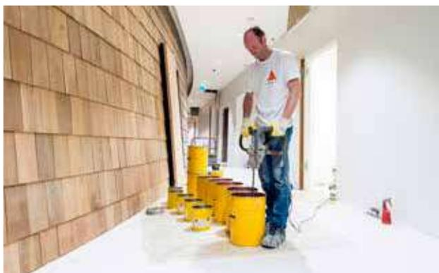
**STEP 1.** Dopo l'ispezione e la preparazione del supporto (pallinatura, levigatura, sabbatura, scarifica e/o livellamento) si inizierà a miscelare i componenti liquidi.
