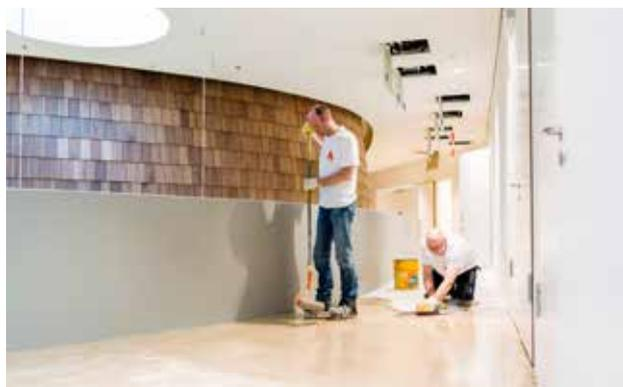
**STEP 2.** Il primer liquido viene applicato per garantire l'adesione del pavimento e viene tipicamente steso a spatola o rullo. L'adeguato metodo di applicazione varia a seconda del tipo di supporto.
