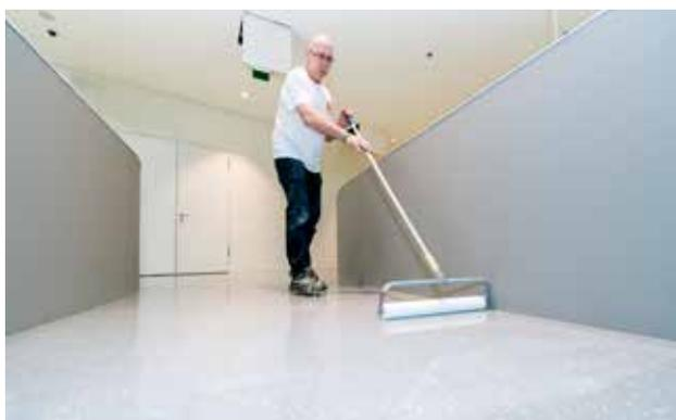
**STEP 5.** Il tocco finale è l'applicazione del rivestimento protettivo trasparente o pigmentato. Di solito l'applicazione viene eseguita a rullo o a spruzzo. Il rivestimento protegge il pavimento aumentando la resistenza all'usura e all'abrasione.
