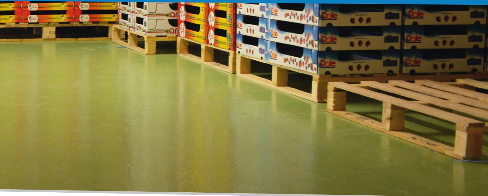
Per l'interno RECODI realizza una **pavimentazione industriale in calcestruzzo dello spessore di 15 centimetri**, a cui è stata applicata una finitura antipolvere per garantire maggiore igiene grazie alla grande facilità di pulizia; vengono inoltre realizzati dei **travetti in resina per rafforzare i giunti di costruzione**, limitando così la rottura degli stessi nel tempo e per facilitare ulteriormente le operazioni di pulitura della pavimentazione.
