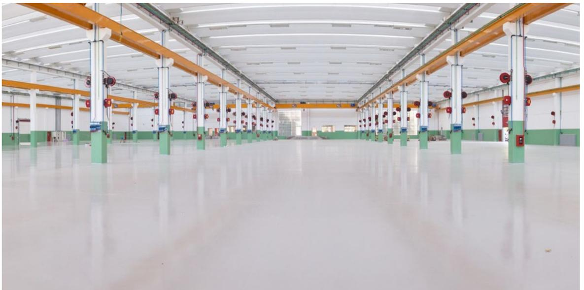
elettrosaldata. La profonda conoscenza del settore ha spinto Recodi, visto e approvato il progetto iniziale, a proporre una serie di migliorie per tutte le zone ovvero l'impiego del metodo della rete passante per i giunti di costruzione e lo studio dei giunti di contrazione con le campiture di ampiezza 10x11 m nell'area di montaggio e di ben 22x25 m nell'area officina.
